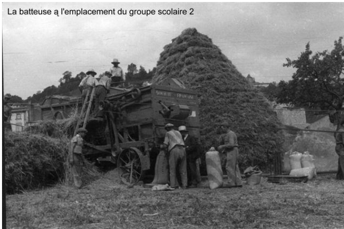
La batteuse à l'emplacement du groupe scolaire 2
