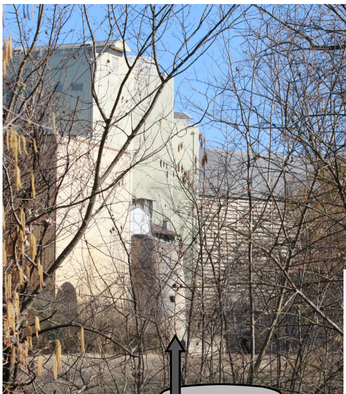
Vestiges de la tour du château de Verdonnet
