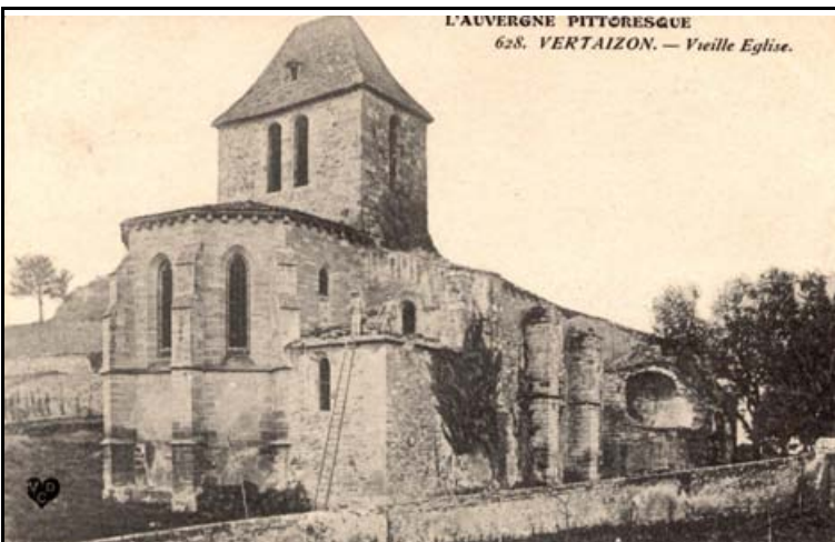
Début de démolition (heureusement stoppée) de ce témoin de nombreux événements à Vertaizon.
