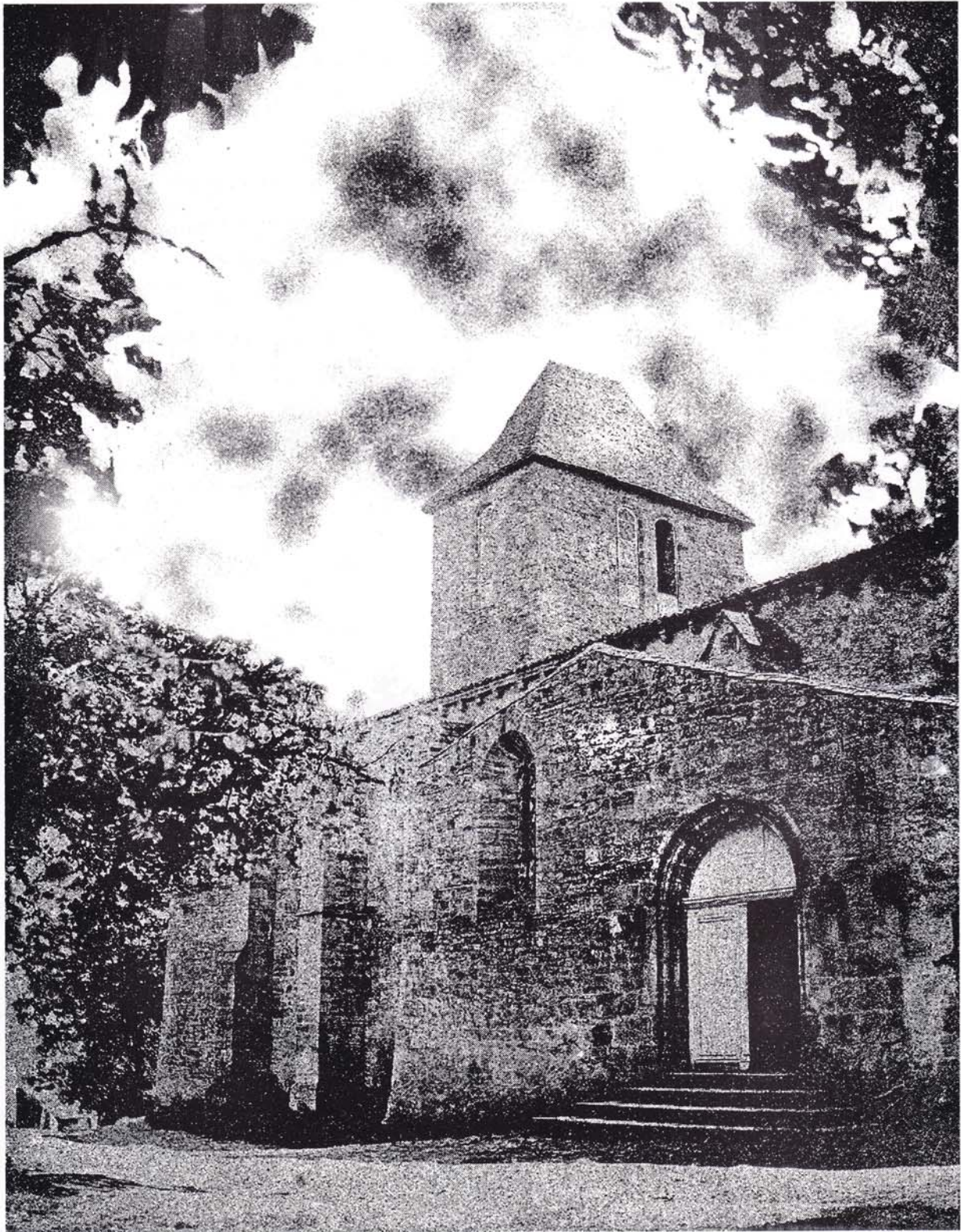
Ancienne église de Vertaizon avant fermeture en 1892 . Original en très mauvais état appartenant à Paul Noyer. L'image a été restaurée à l'ordinateur durant l'année 2000 par Michel Diou.
