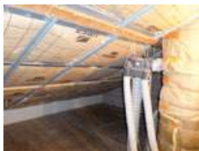
• Des combles isolés gage de confort et d'économie d'énergie
