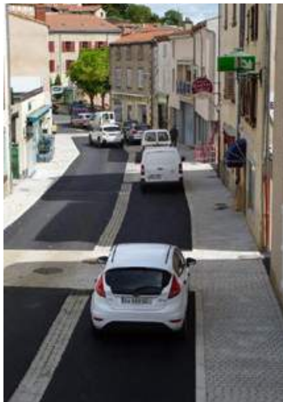
• Rue Jean Jaurès après les travaux.
